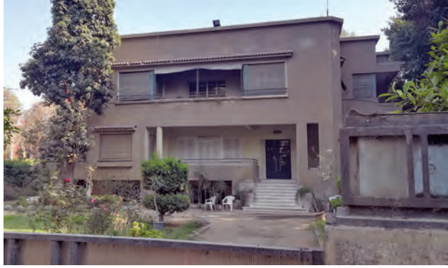
لوحة رقم (٣٦)، فيلا ٢٩ شارع أبو الفدا على الطراز الحديث وتظهر الصفة الغالبة على الواجهات في التشكيل باستخدام الفتحات العرضية والمسطحات الناعمة وقلّة التشكيل بالزخرفة وخط الأفق المستوي
