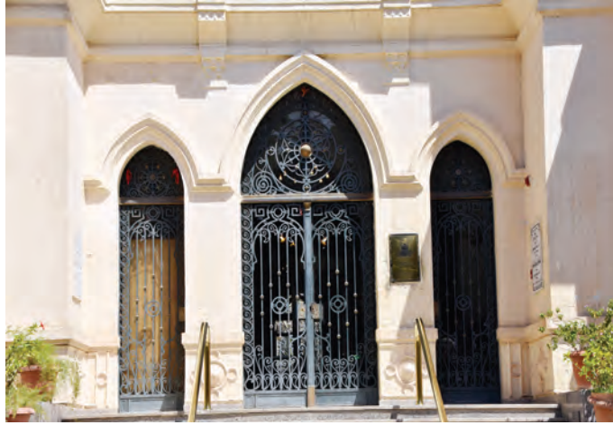
لوحة رقم (٢٤) الزخارف الحجرية البارزة اعلى الفتحات والكرانيش المستمرة بعرض المبنى محددة للأدوار والكرادي الحاملة للكرانيش
