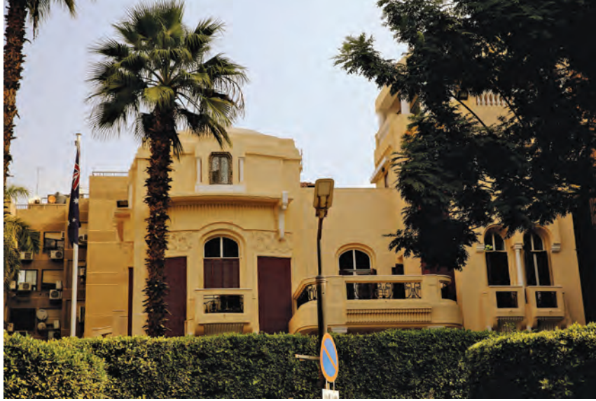
لوحة رقم (٣٣)، ٢٣ احمد حشمت ويظهر بها سمات تكوينية واضحة من الأرت ديكو في الشريط الزخرفي المبتكر باستخدام الأشكال النباتية المجردة أعلى فتحات الشبابيك والحديد المشغول في الشرفات مع تنوع كبير في خط الأفق والخطوط الناعمة في تشكيل عناصر وخطوط الواجهة مع خلق بروز وإرتداد على طول الواجهة
